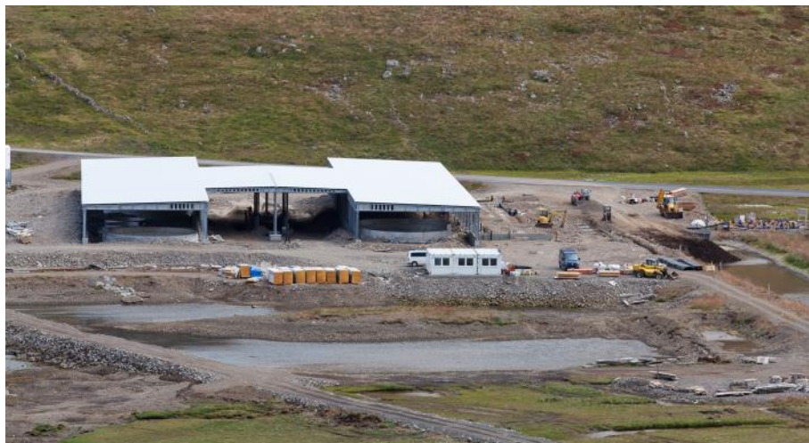
Mynd 5. Eldishús Arctic Smolt í Norður Botni í Tálknafirði þar sem búið er að byggja yfir körin en eftir að klæða veggina. Til hægri er verið að byrja á viðbyggingu fyrir hrogn og frumfóðrun seiða.
