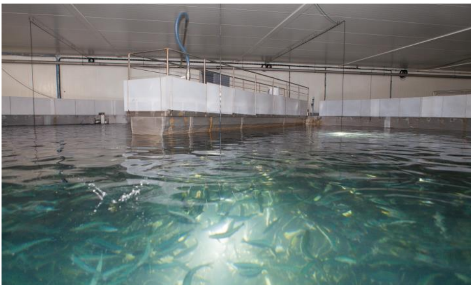
Mynd 9. Lýsing undir vatnsyfirborði í einu eldiskaranna hjá Arctic Smolt.
