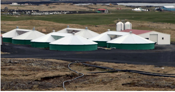
Mynd 9.2. Yfirbygging yfir kör hjá Íslandsbleikju á Stað (Ljósmynd: Valdimar Ingi Gunnarsson).
