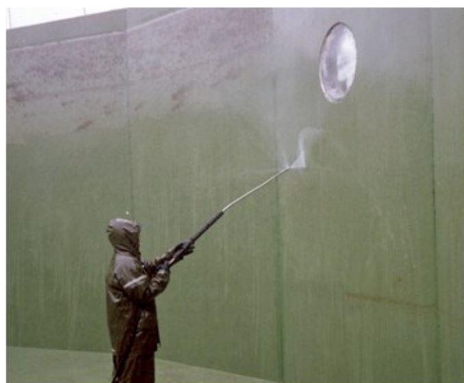
Mynd 9.19. Hringlaga kar hreinsað að innan með háþrýstisþúl (Ljósmynd: Valdimar Ingi Gunnarsson).
