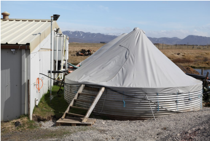
Mynd 9.3. Plastdúkur notaður til að byggja yfir lítið kar hjá Íslenskrri matorku (Ljósmynd: Valdimar Ingi Gunnarsson).
