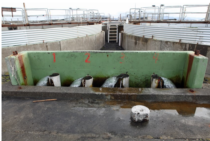
Mynd 9.16. Frárennislagnir úr fjórum körum koma saman upp í einn frárennislisstokk hjá Íslandsbleikju á Stað (Ljósmynd: Valdimar Ingi Gunnarsson).
